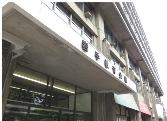
築50年の「岩手教育会館」が建て替えられる。完成は2018年2月(予定)だそうだ。(盛岡建設労働組合 大向 祐司さんより投稿)
